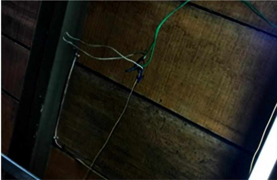
Techo en madera dentro del área de soldadura, además de cables sueltos en el mismo.
