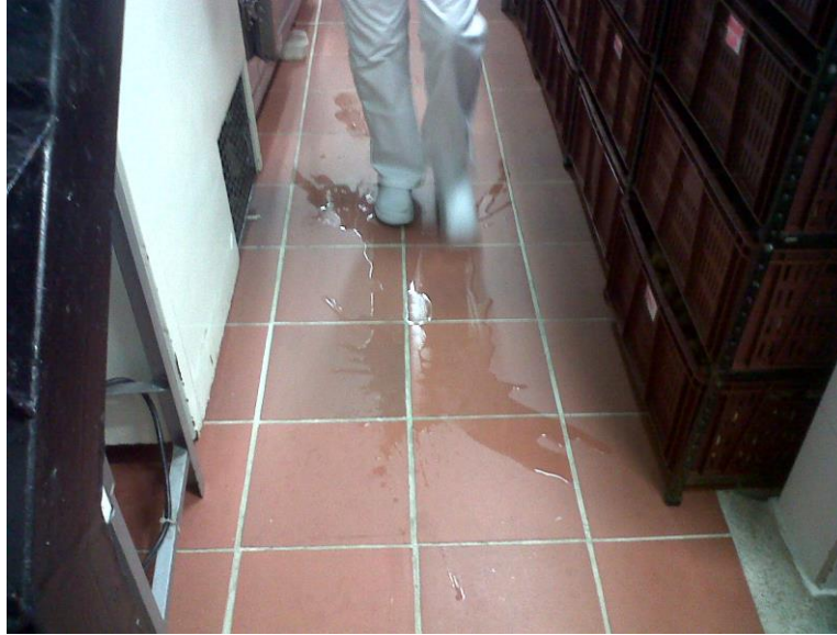
Figura 14. Caídas al mismo nivel, piso húmedo.
