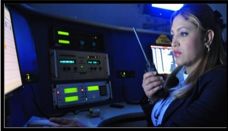
Figura 5. Operador de medios en la central de monitoreo
